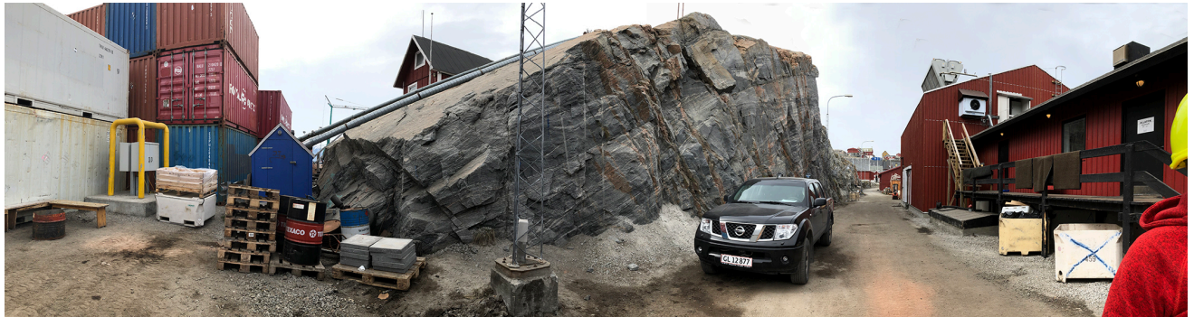
Kimmut Pavia Leibhardtsip Aqquataa tungaanut qivaraanni. Takuneqarsinnaavoq qeqqani qaarsortaq kommunimut pilersaarutip tapiani sanaartorfissatut aalajangiussat inissaqartilerumallugit qaartiterneqartussaq | Kig mod vest mod Pavia Leibhardtsip Aqquataa. I midten ses fjeldet der skal bortsprænges for at frigøre plads til kommuneplantillæggets byggefelter.
