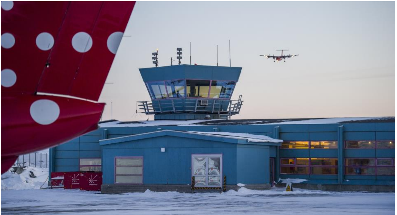
Mittarfiup illorsuartaq piusoq | Eksisterende lufthavnsterminal
