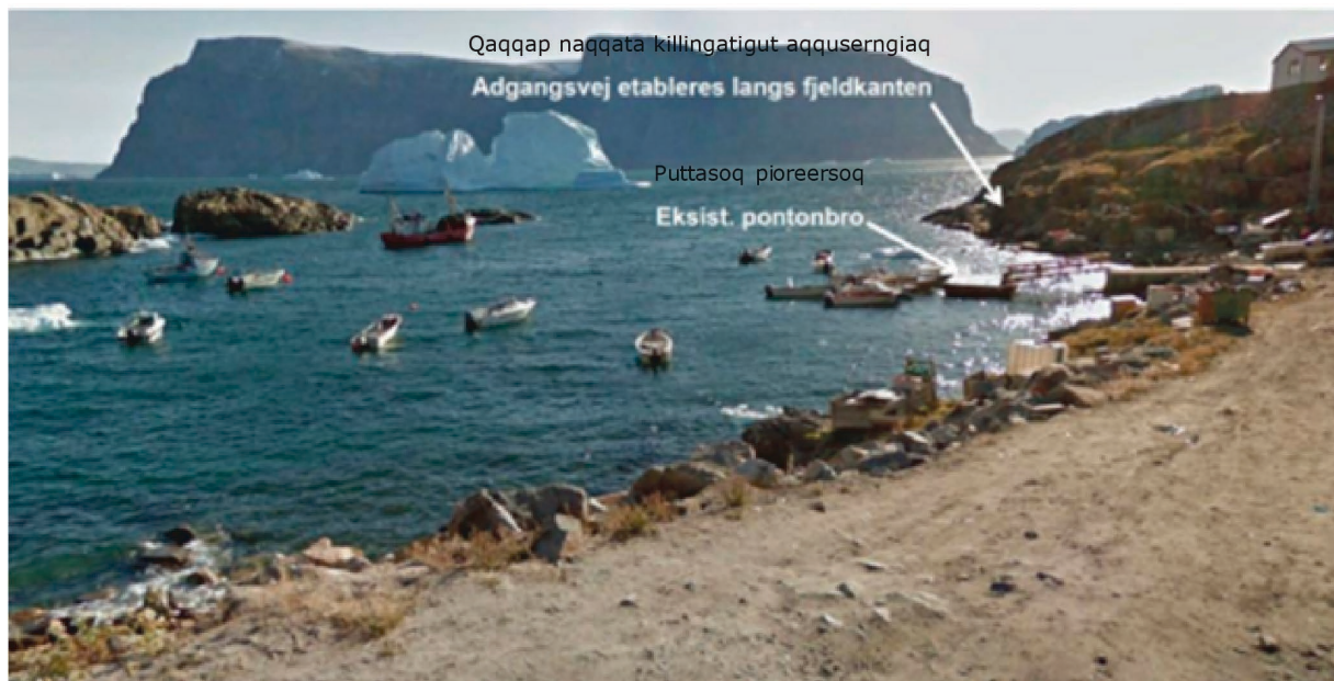
Maanna pissutsit atuuttut, mittarfeeqqap tungaanut | Eksisterende forhold, kig mod heliport.
